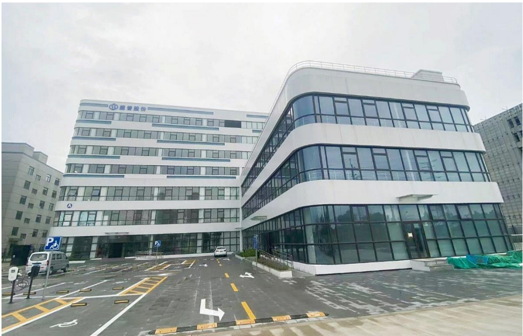
2022 年 12 月盛普智能在建工程外景实拍
