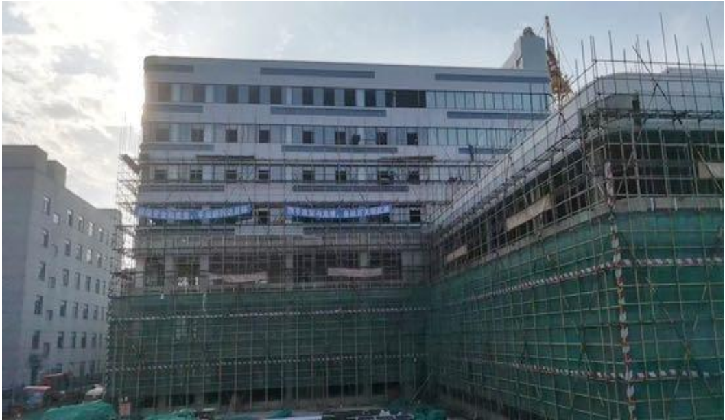
2021 年 12 月盛普智能在建工程外景实拍
