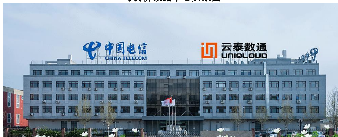
马驹桥数据中心实景图
