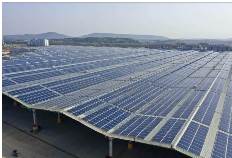
发行人江西丰城生产基地光伏厂房
