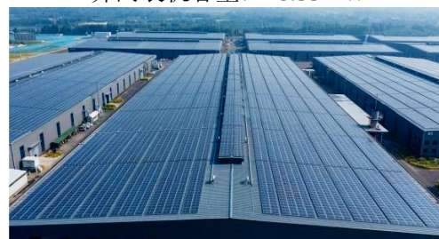
泰安市绿色建材产业园 并网装机容量：18.53MW
