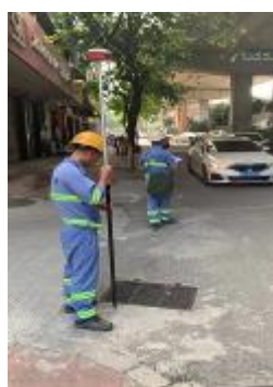
GNSS RTK 测量现场
