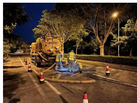
思明区项目作业现场
