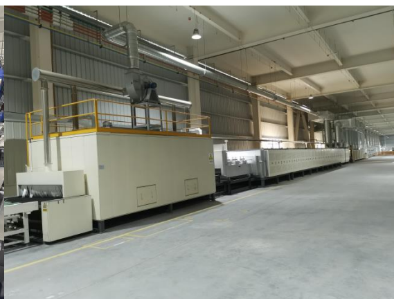
NOCOLOK 钎焊炉钎焊
