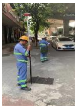
GNSS RTK 测量现场
