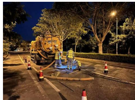
思明区项目作业现场
