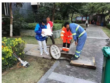
思明区管道探测现场
