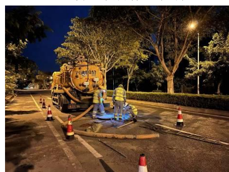
思明区项目作业现场
