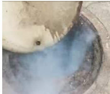
烟雾试验现场
