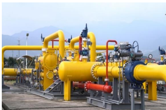
金华市区天然气高压输配工程
