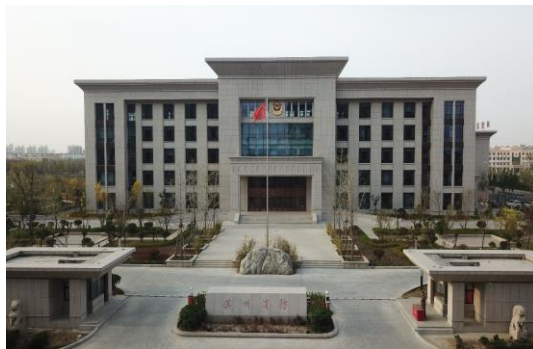
滨州市公安消防支队特勤消防站及站勤保障消防站工程
