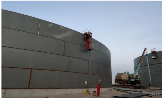
滨州中海管道输油专线 500 万吨/年工程项目 滨州港站无损检测工程
