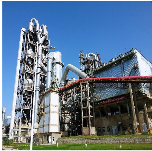
（台泥水泥项目）
