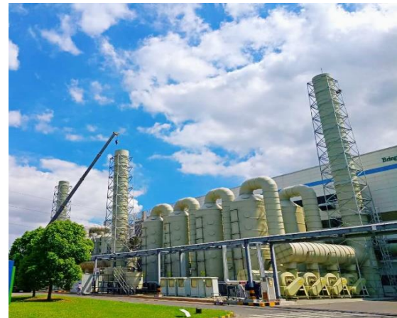
（扬州协鑫光伏项目）
